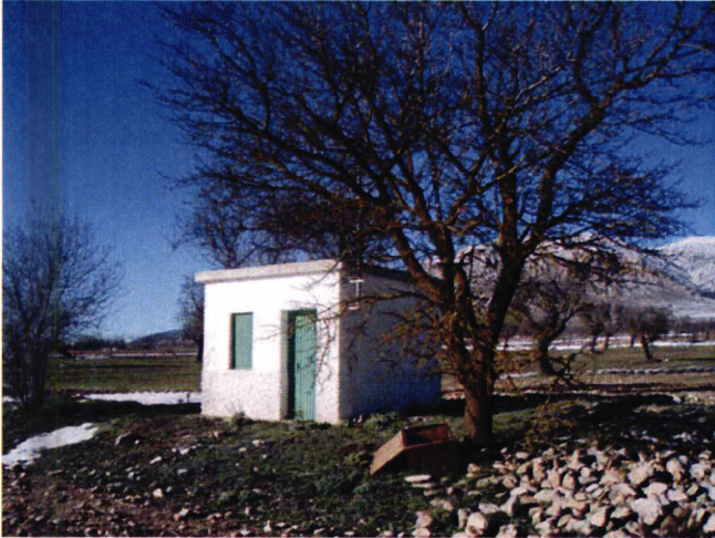
Foto 1. Pozo Celestino, Cúllar.
